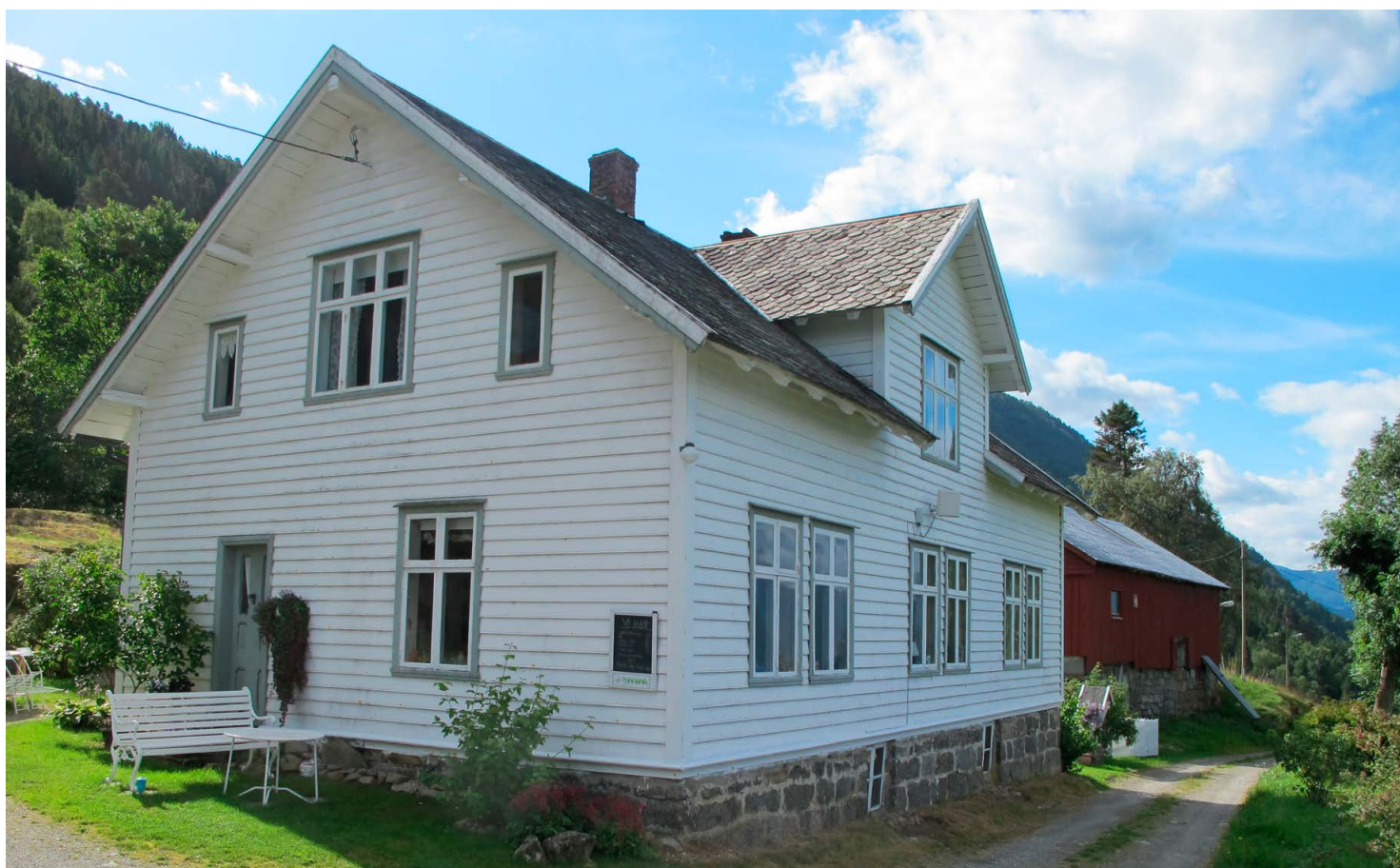
Theodorhuset har fått sitt navn etter Kjerstis grandonkel. Huset på Hovland gård ble bygget i 1907 av Kjerstis oldeforeldre på farssiden. Huset er godt bevart, med originalt panel, dører, vinduer, listverk og skifertak. Legg også merke til den flotte gråsteinsmuren.
